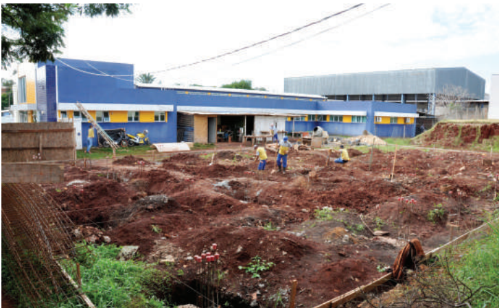
Obras de construção da nova Unidade de Saúde na região central
