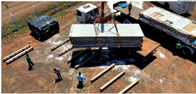
(Ibape-PR). O contrato com a Tecverde impõe prazo de 180 dias para a construção de todas as 320 casas.
